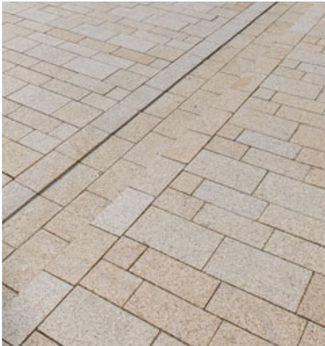
Offene Rinnen Betonpflaster
