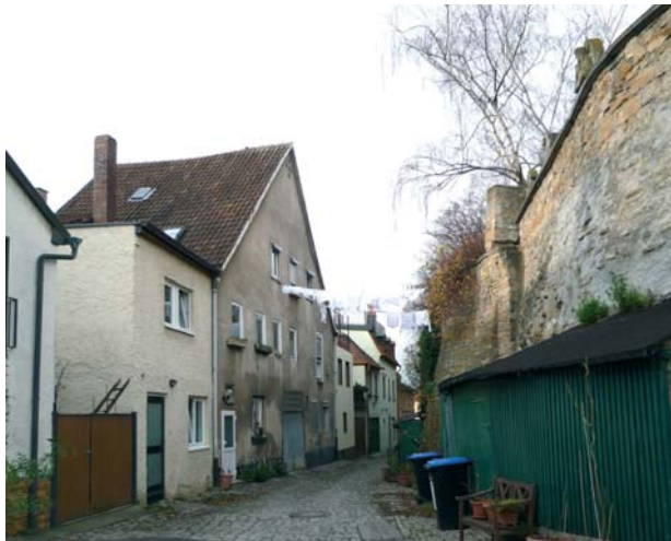
Wohnbebauung westliche Schuhstraße von Braugässchen aus gesehen
