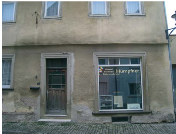
Schlechter Erhaltungszustand alter Bausubstanz in der Weiße-Turm-Straße
