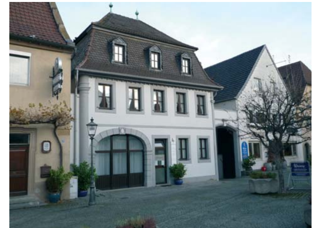
Rügshöfer Straße - Laden- und Wohnnutzung
