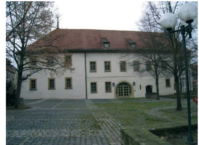
Spitalgarten mit Pflasterbelag und wenig Ruhezonon (G 5)
