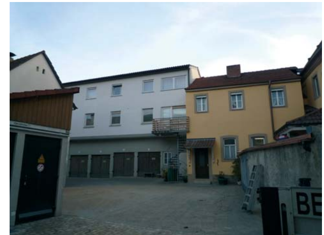
Hinterhofsituation in der westlichen Rügshöfer Straße
